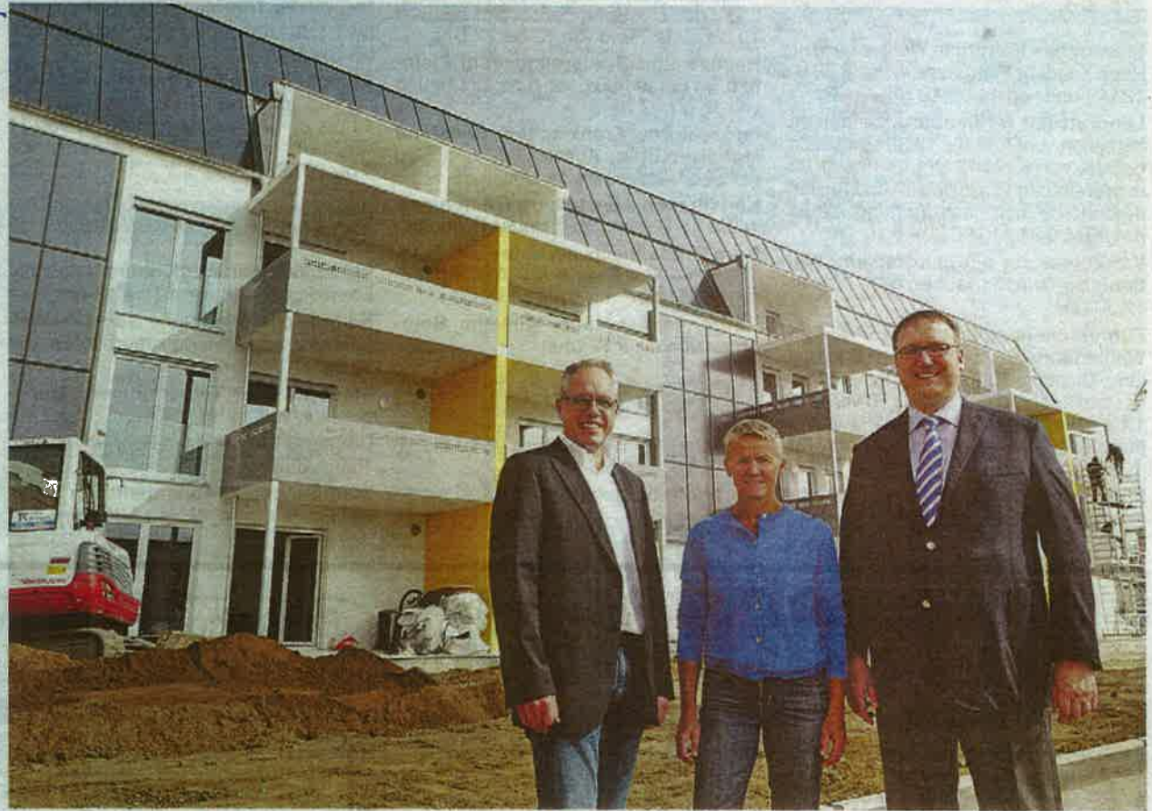
Freuen sich, dass die insgesamt 19 Wohnungen der „Sonnenhäuser“ eineinhalb Jahre nach dem Spatenstich bereits bezogen werden: Architektin Michaela Bittner, Eigenheim-Vorstand Thomas Hanke (links) und Aufsichtsratsvorsitzender Bernd Körzendörfer (rechts). Das ökologische Vorzeigeprojekt ist bayernweit einmalig. Foto: Steiner
