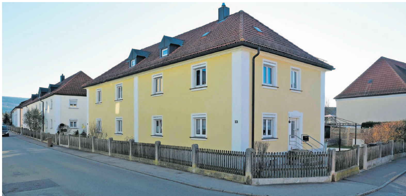
Typisch Steinleinsfurt: So oder so ähnlich sehen die Gebäude in weiten Teilen des Quartiers aus. Sie sind zum Teil fast 100 Jahre alt und sollen nach den Plänen der Wohnungsgenossenschaft Eigenheim in den nächsten Jahren durch Neubauten ersetzt werden.
