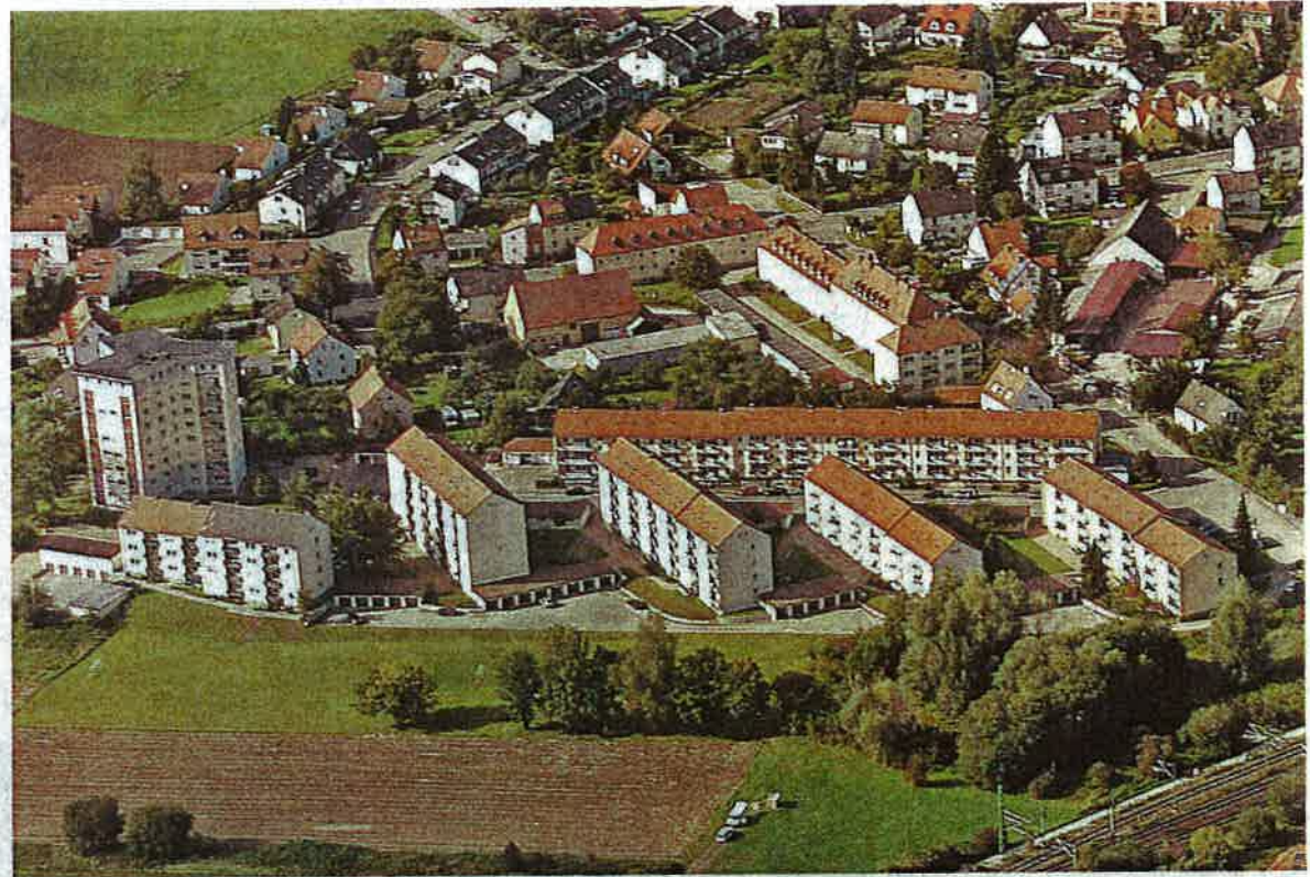
Die Heizungen kommen in die Jahre: Die Gebäude der Wohnungsgenossenschaft Eigenheim an der Kaadener, Alten Weimersheimer und Emetzheimer Straße haben derzeit jeweils eigene Heizungsanlagen. Eine Machbarkeitsstudie ergab, dass als zukunftsichere Lösung für die 206 Wohnungen eine zentrale Hackschnitzelheizung ideal wäre. Foto: www.limes-luftbild.de
