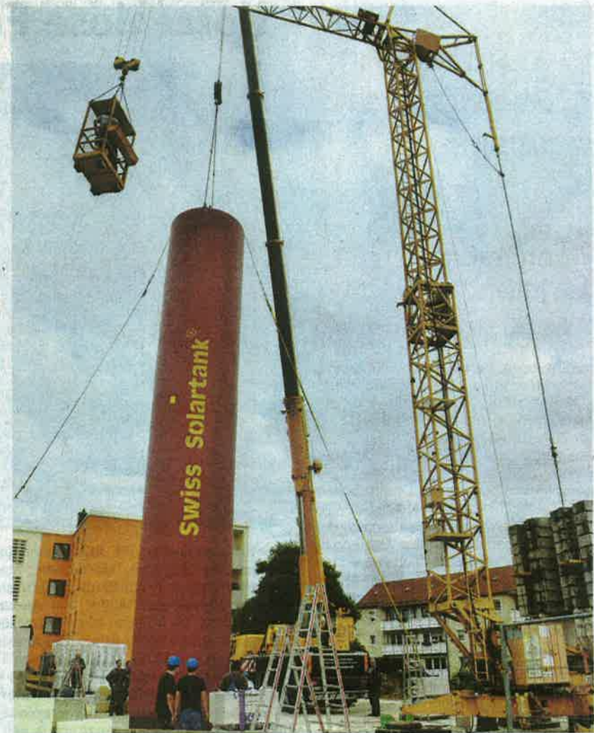
Zentimeterarbeit mit Riesenbehältern: Gestern wurden im künftigen „Sonnenhaus“ der Wohnungsgenossenschaft „Eigenheim“ Weißenburg zwei dieser mächtigen Warmwasserspeicher eingebaut. Foto: Heubeck
